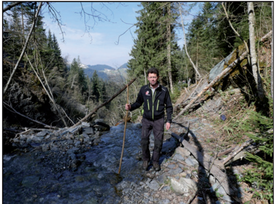
Abb. III.3.2: Wildbachbegehungen und laufende Überwachung der Schutzbauwerke durch die Gemeindewaldaufseher sind wichtige Elemente zur Gefahrenprävention. (Foto: Land Tirol)
